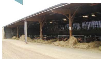
2002 : construction du bâtiment de 1 400 m 2 qui couvre la chèvrerie "adulte".
